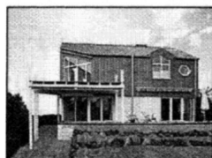
Aus- und Umbauten Baureparaturen
